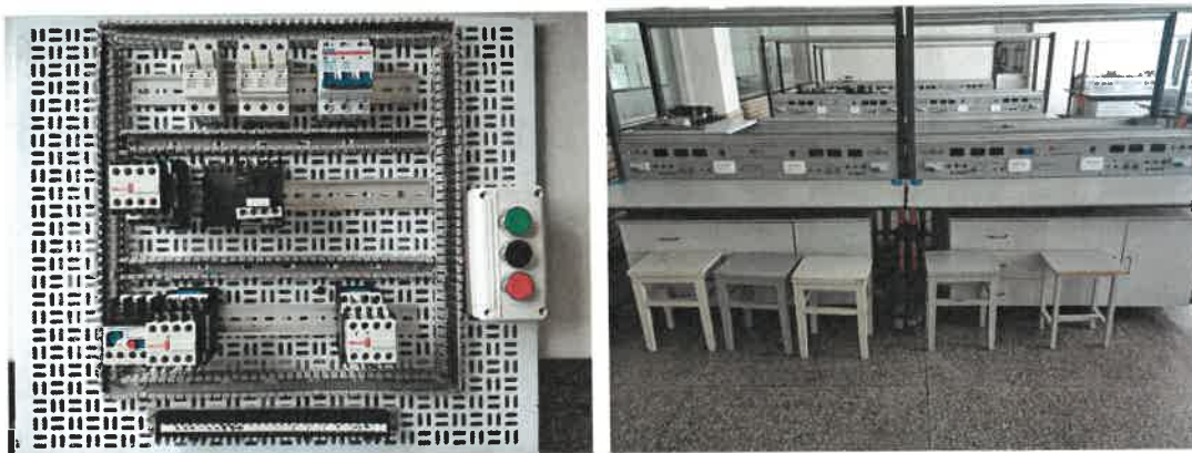
图1 实操—电气安装及调试场地及元器件
